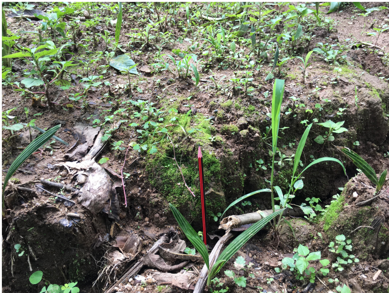
照片 2 斜坡地裂缝
